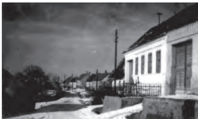
Fotografia zachytáva pôvodnú elektrickú rozvodnú sieť, vybudovanú v roku 1942
